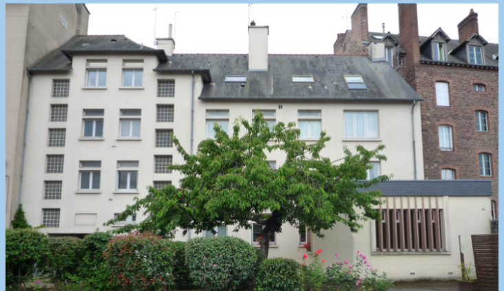
Vista interior: parking y jardín. A la derecha la pequeña capilla
