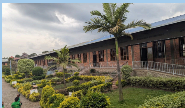
Premier bâtiment scolaire. Le projet consiste à ajouter un étage
