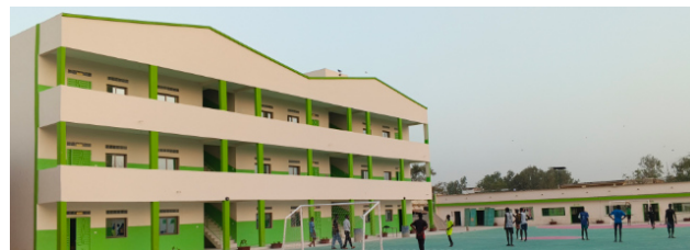
Nouveau bâtiment et terrain de sport
