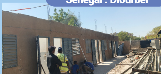
Rénovation de l'internat
