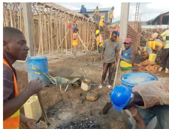
La construction du réfectoire se poursuit activement à Gisenyi. Les locaux sous le réfectoire, salle de bibliothèque et salle d'informatique sont bien solides.
