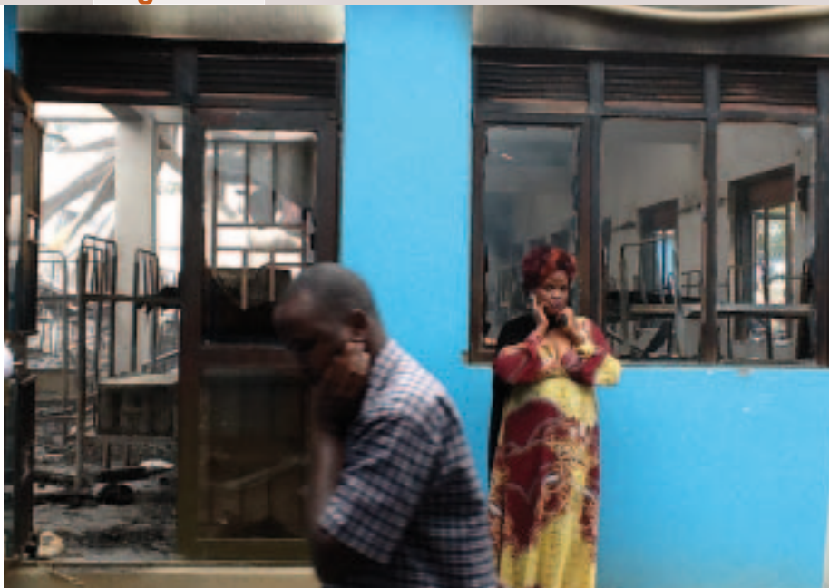
Les dortoirs ont été entièrement détruits. The dorms were completely destroyed. Los dormitorios han sido totalmente destruidos.
