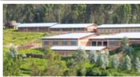
Ravitaillement d'eau, Kirambo (Vue générale)
